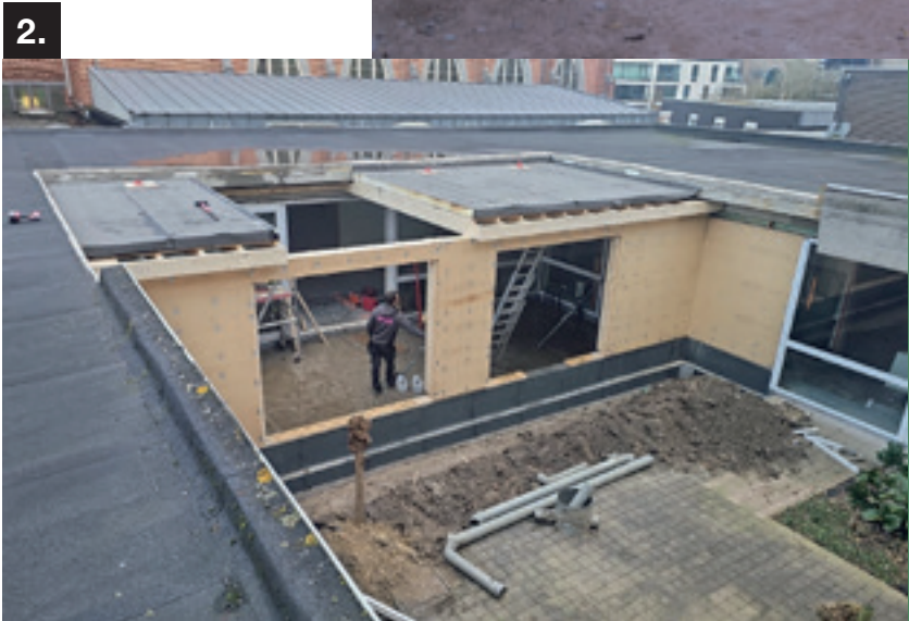
Uitbreiding (optopping en aanbouw)
